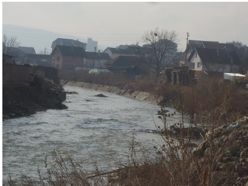
Sl. 04: Reka Raška – kraj izvedene regulacije, uzvodno od ušća Deževe
